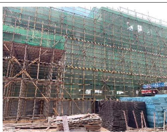
东南侧：在建厂房
